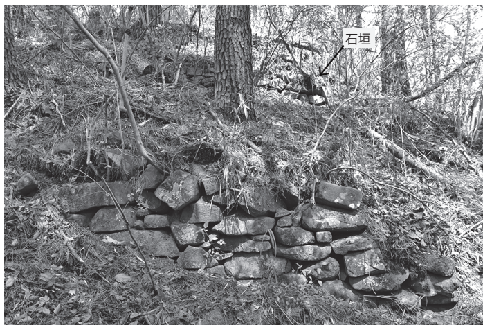
⑬ 虎口bの平たい石を使ったセットバック石垣
